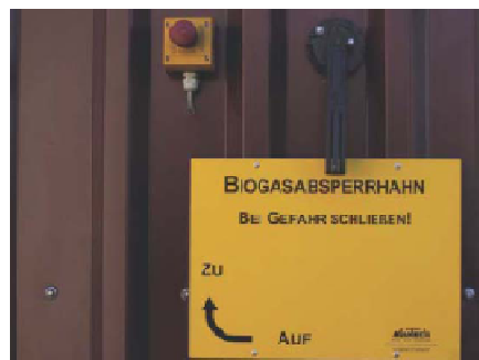
Bild 4: Gasabsperrhahn einer Biogasanlage
